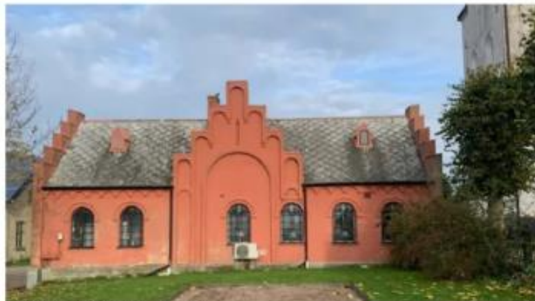
Vadensjö byastuga ska nu äntligen renoveras.
